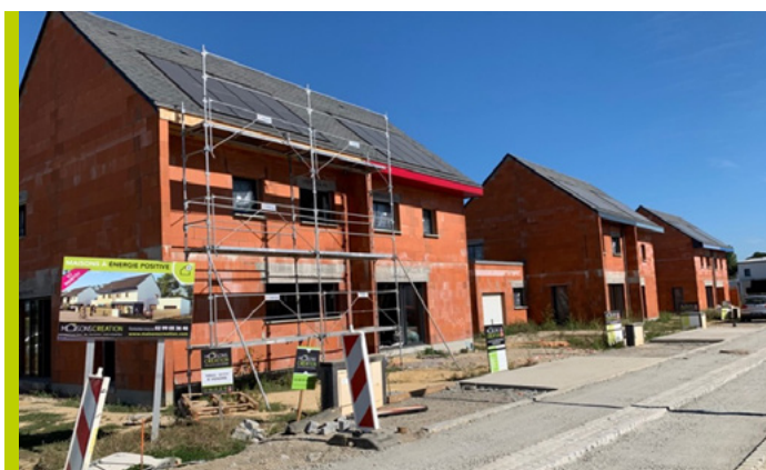
Maisons en cours de construction
